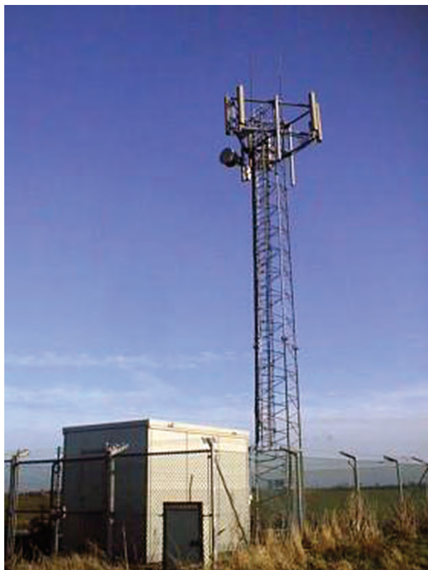
Slika 1: Primjer bazne stanice mobilne telefonije
